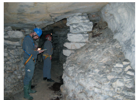
Photo 3 : Surveillance d'une ancienne carrière souterraine (Cliché Inspection générale des carrières - Mairie de Paris)
