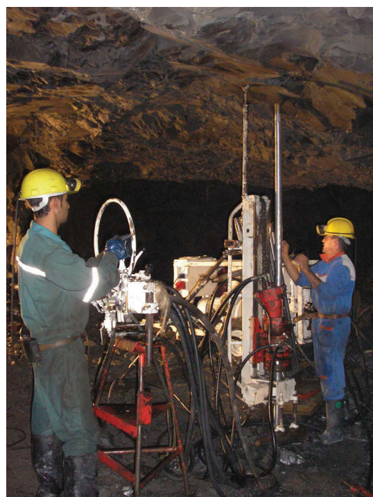
Photo 5 : Chantier d'exploration en souterrain (Cliché Paulo Ferraz, SOMINCOR)
