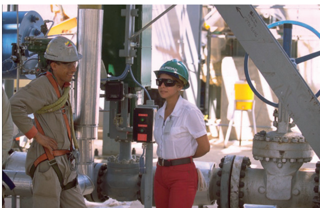
Photo 4 : Forage pétrolier au Venezuela (Cliché Pierre Bessard, Total)
